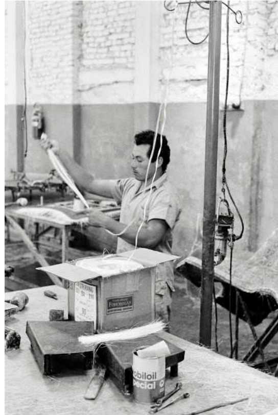
Das Fiberglas wird den Boxen entnommen. Hier begann die manuelle Produktion der Pumas.
