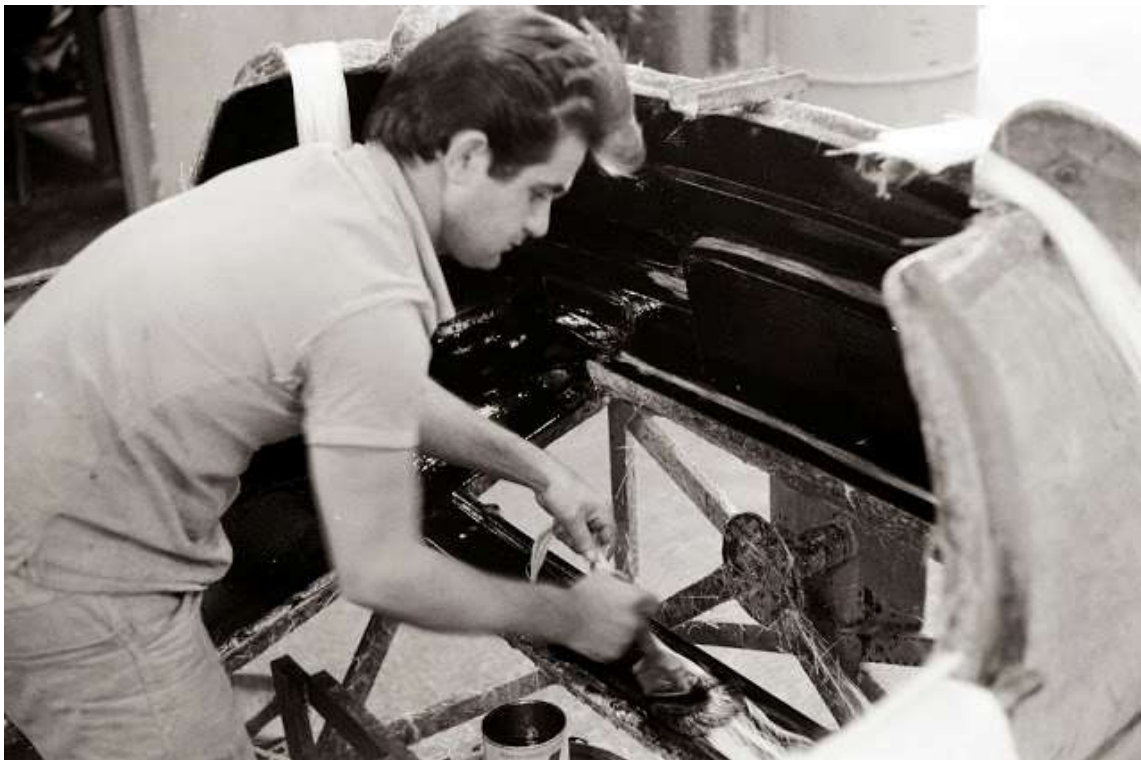
Mitarbeiter belegen die Karosserieform mit den Glasfasern und dem Giesharz. Da es keine Pistolen gab, wurde die Arbeit mit Bürsten erledigt und erforderte daher mehr Zeit und Arbeit.
